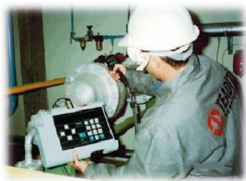
Monitoramento de Emissão, através do OVA, em flange.
